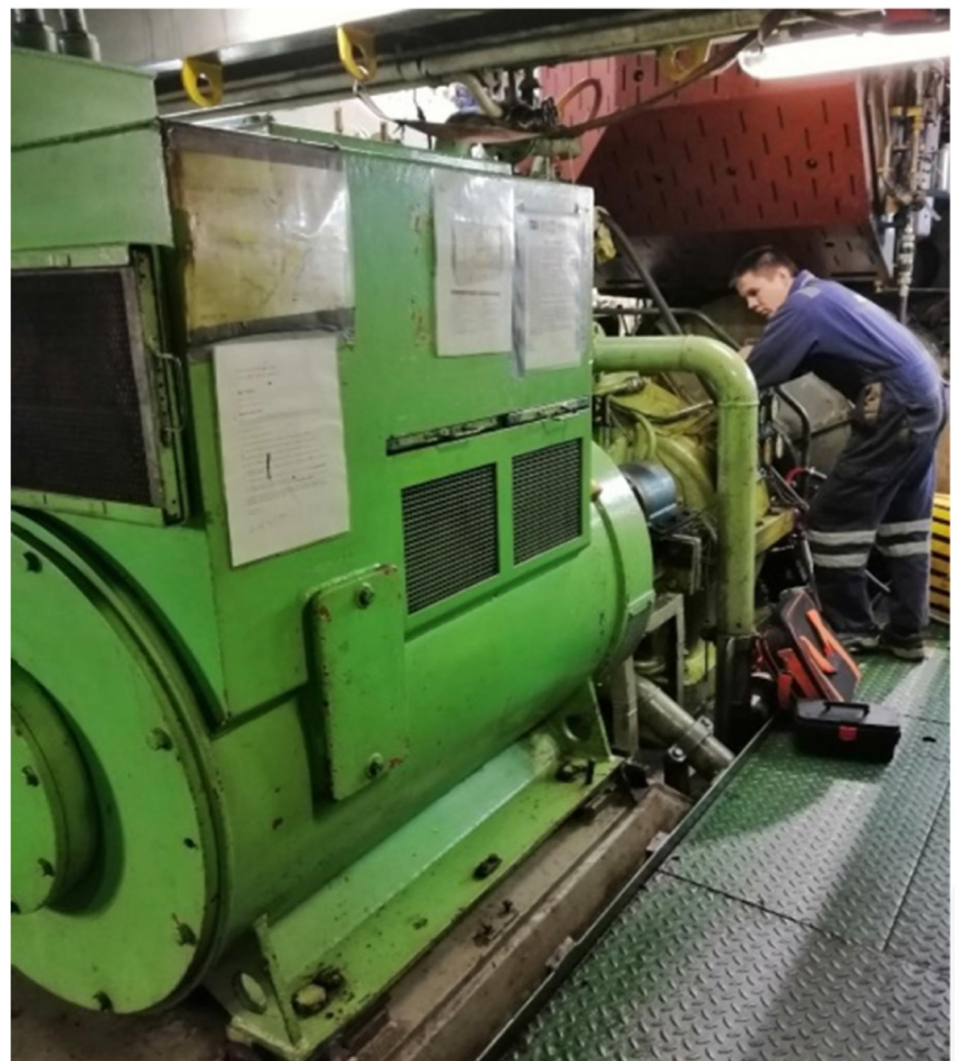
В результате измерения несоосности, программа рассчитала смещение задней пары лап на 7,80 мм ниже уровня фундамента.
