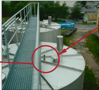
Место установки уровнемера ТИТАН-136У
