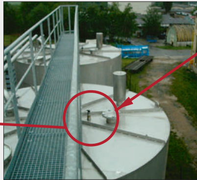
Место установки уровнемера ТИТАН-136У
