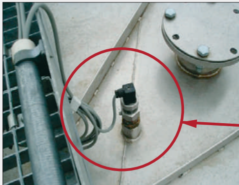
Место установки уровнемера ТИТАН-136У
